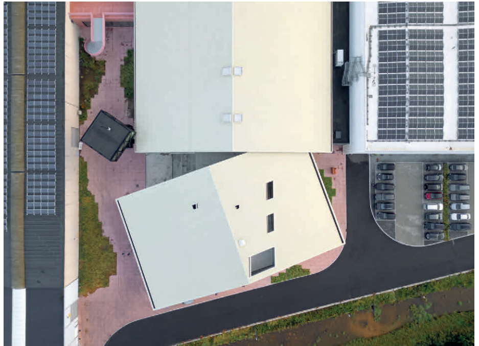
Mit dem neuen Campus in Zulte hat Sobinco seinen Stammsitz zu einem modernen Industrie- und Entwicklungsstandort ausgebaut. Die Erweiterung vereint Produktion, Entwicklung, Verwaltung und Logistik unter einem Dach.
